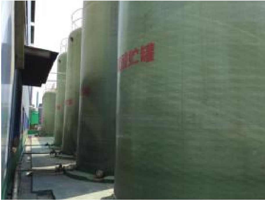
废酸（稀硫酸）储罐
